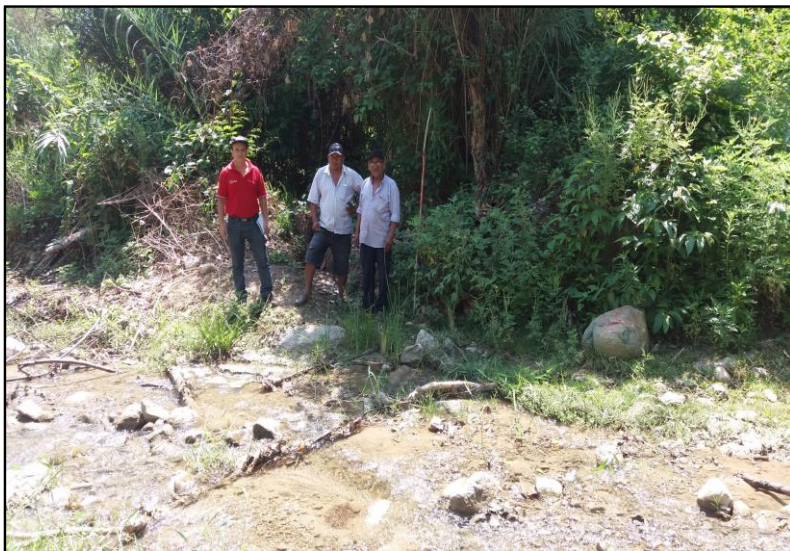
Fotografía N°04: Se observa la toma rústica del canal Piñón 02, quebrada carrizal, en donde es necesario la construcción de un muro de mampostería de 15 m. de largo X 1.5 m. de altura.
