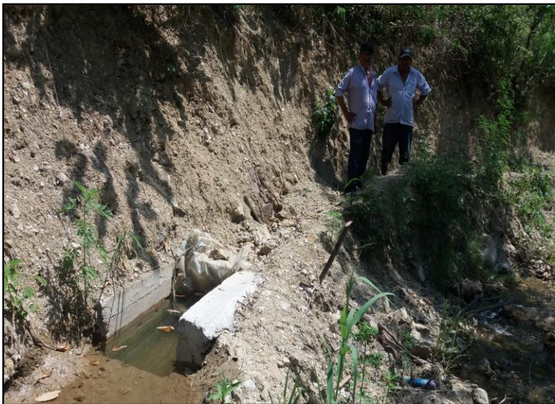
Fotografía N°04: Se observa la toma rústica del canal Piñón 02, quebrada carrizal, en donde es necesario la construcción de un muro de mampostería de 15 m. de largo X 1.5 m. de altura.
